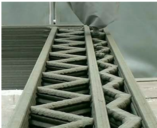
Рис. 2. Заполнение стен строительной смесью при контурном строительстве
