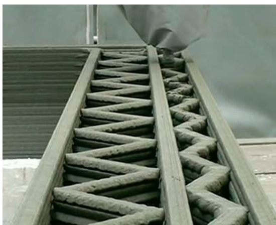
Рис. 2. Заполнение стен строительной смесью при контурном строительстве
